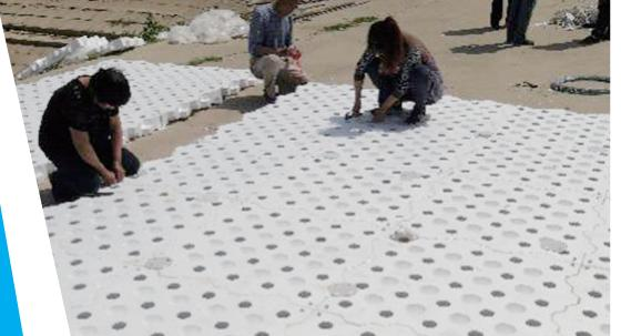
5月13日，北京市水产技术推广站推广科技术人员赴小务基地开展了“生物浮床治理池塘富营养化技术”的试验示范工作，该项技术实现了养鱼不换水、种菜不施肥、资源可循环利用的目标。技术人员现场指导工人拼装完成了400平方米的泡沫浮床并栽种了3.5万余株水稻秧苗，实现了“水下养鱼、水面种稻”的立体养殖效果。
